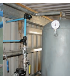
5. Livraison du chantier en un temps record
