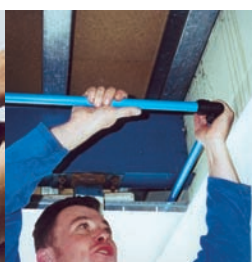
3. Mise en œuvre dans les espaces confinés
